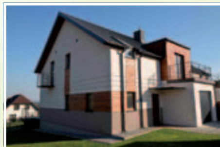
Budynek Barbara - elewacja wejściowa
